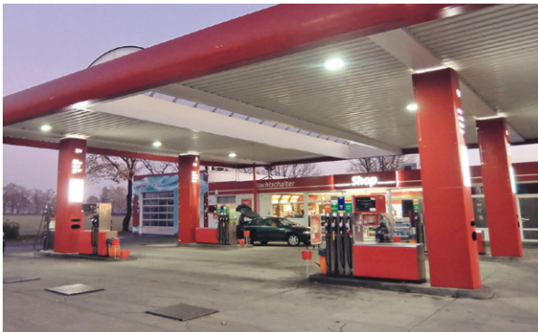
LED-Beleuchtung im äußeren Tankstellenbereich
