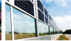
Photovoltaik-Lärmschutzwand
