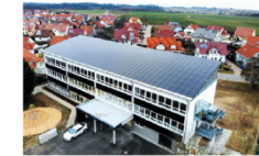
Schule mit Photovoltaik-Dach
