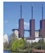
Groß-KWK mit GuD-Anlage 300 MW el
