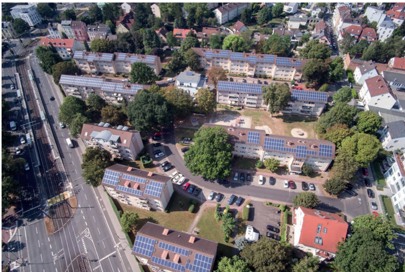
Abb. 22: Mieterstromprojekt in Frankfurt a.M. (Quelle: Mainova AG)
