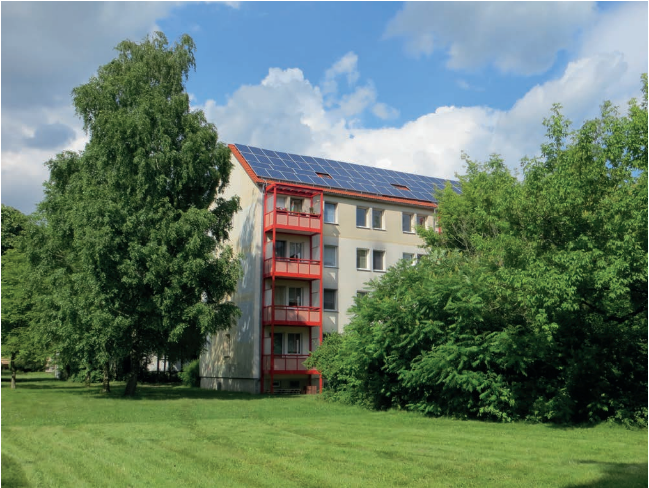
Abb. 20: Mieterstromprojekt in Wolfen (Quelle: Engynious GmbH / Karl Zrost)
