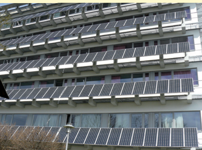
Bild: Krankenhaus Mühlacker
