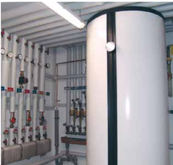
Bild 2: Pufferspeicher
