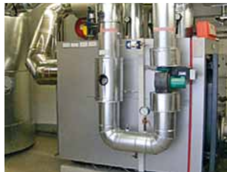
Bild 2: Spitzenlastkessel
