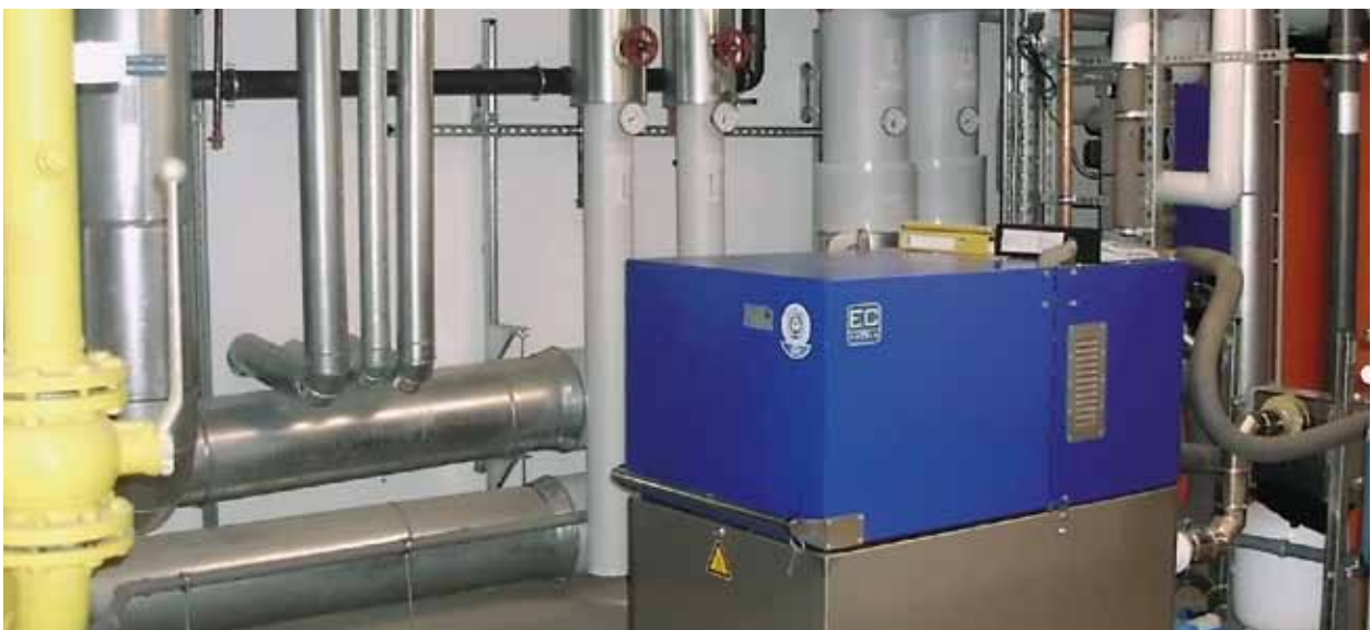
Bild 2: BHKW-Anlage
