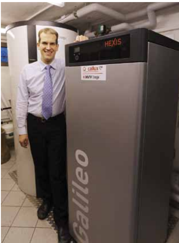
Bild 2: Typische Installation einer Hexis-Brennstoffzellenheizung
