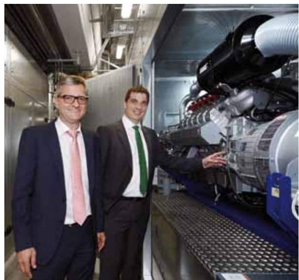
Bild 3: Inbetriebnahme BHKW am 17.07.2014
