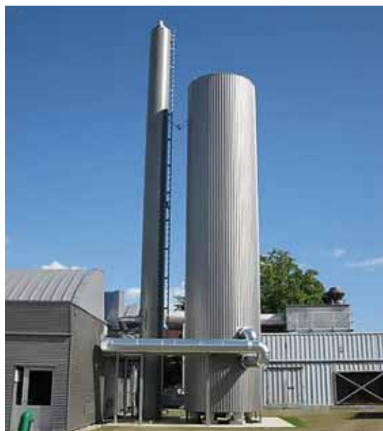
Bild 1: Pufferspeicher und Kamin
