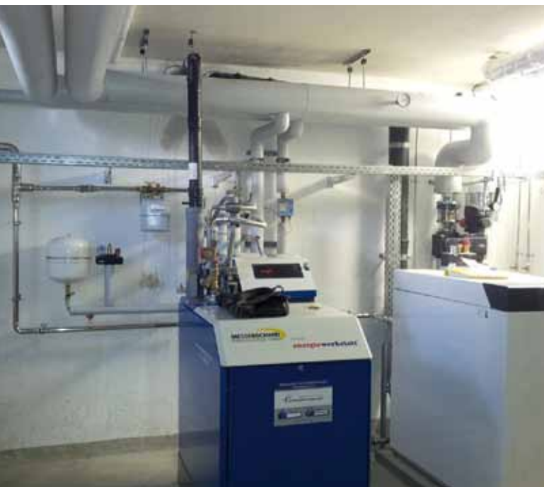
Bild 2: BHKW-Anlage
