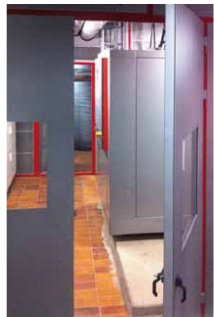
Bild 2: Nach Schließen dieser Tür dringen nur 35 Dezibel aus der Schallschutzkabine
