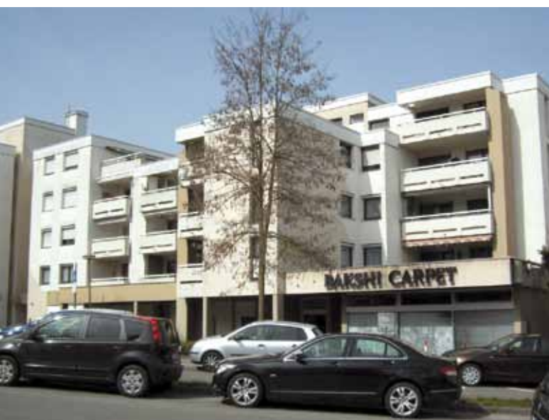
Bild 1: versorgtes Objekt (Mehrfamilienhaus mit 34 Wohneinheiten)
