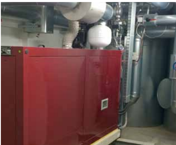
Bild 2: BHKW-Anlage
