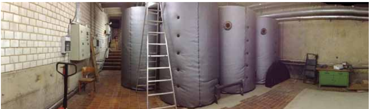
Bild 3: Bauabschnitt 1 Heizzentrale Thiebauthschule Ettlingen
