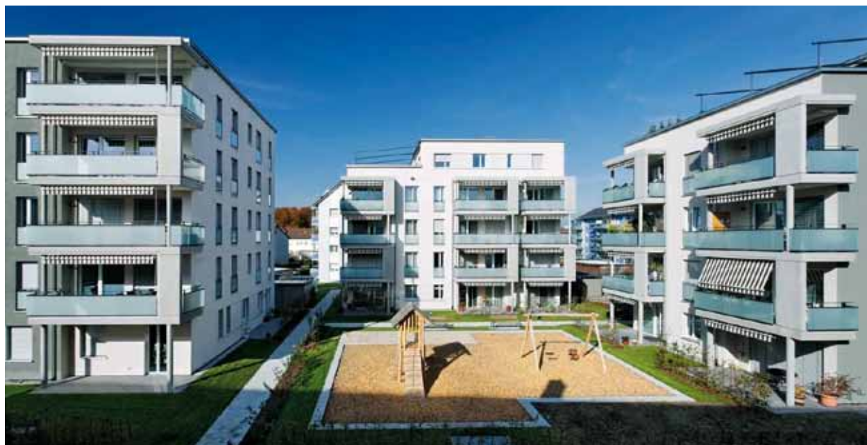
Bild 1: Versorgtes Wohngebäude in Offenburg
