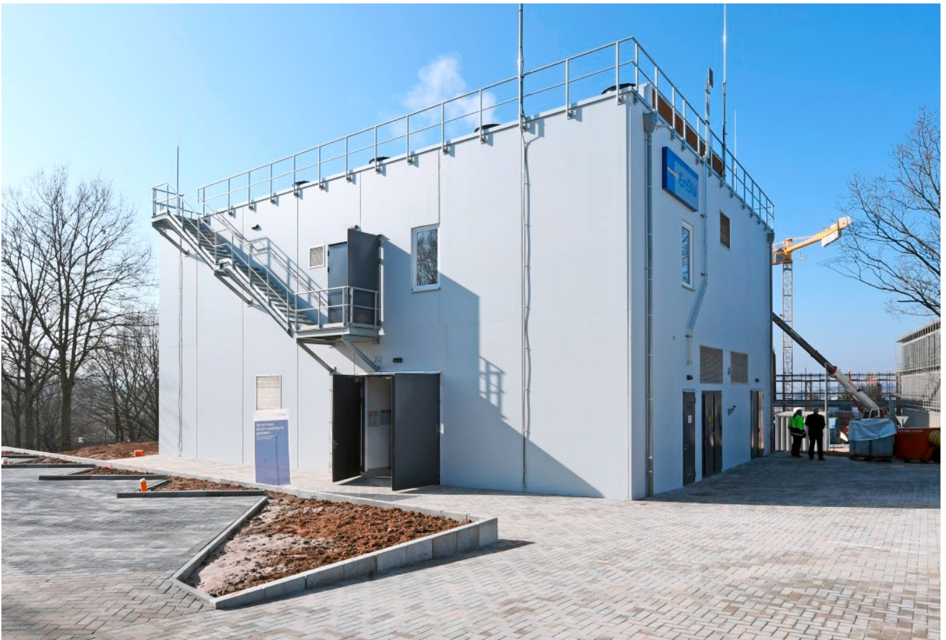
EnBW Energieverbundzentrale Waldbronn
