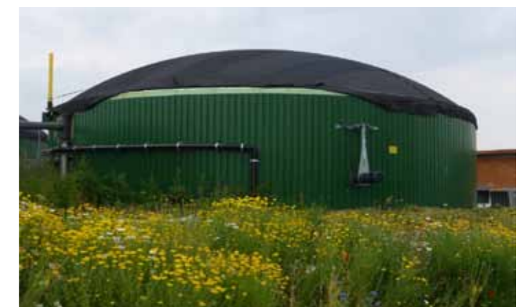
Abbildung 33: Biogasanlage Bäuerle in Kleinaspach
