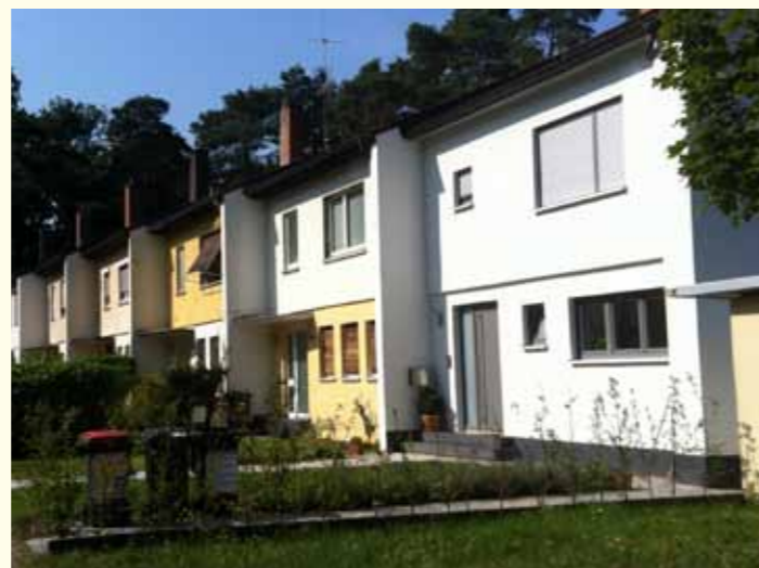
Abbildung 11: Durch gemeinsame Sanierung gleicher Gebäude werden auch Synergien bei der Datenerfassung erzielt.
