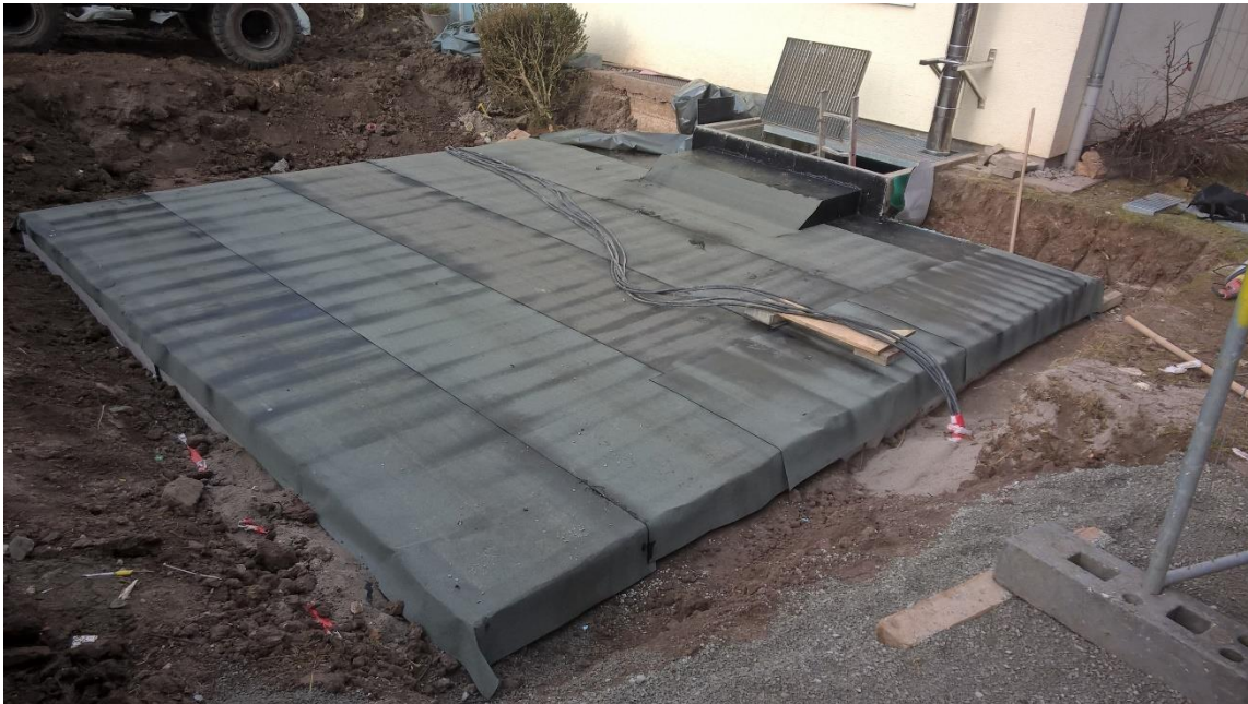
Energiezentrale (Dach mit Abdichtung) Quelle: ZEAG Energie AG
