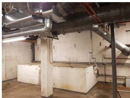
vollständiger Rückbau der überdimensionierten Trinkwassererwärmungsanlage und Aufteilung auf drei dezentrale Durchfluss-TWE, Nachrüstung geeigneter Regulierventile
