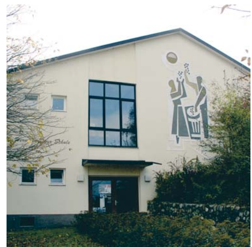
Hermann-Daur-Schule mit Mehrzweckhalle in Weil am Rhein, Ortsteil Ötlingen
