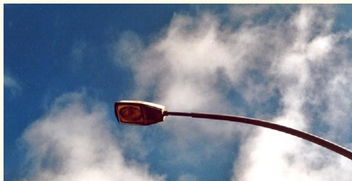
Leuchte mit Natriumdampf-Hochdrucklampen
