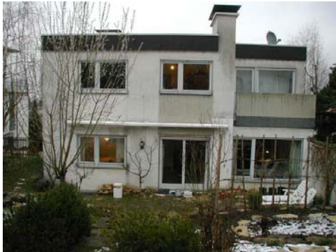
Vor Modernisierung Gartenseite
