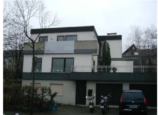
Nach Modernisierung Strassenseite
