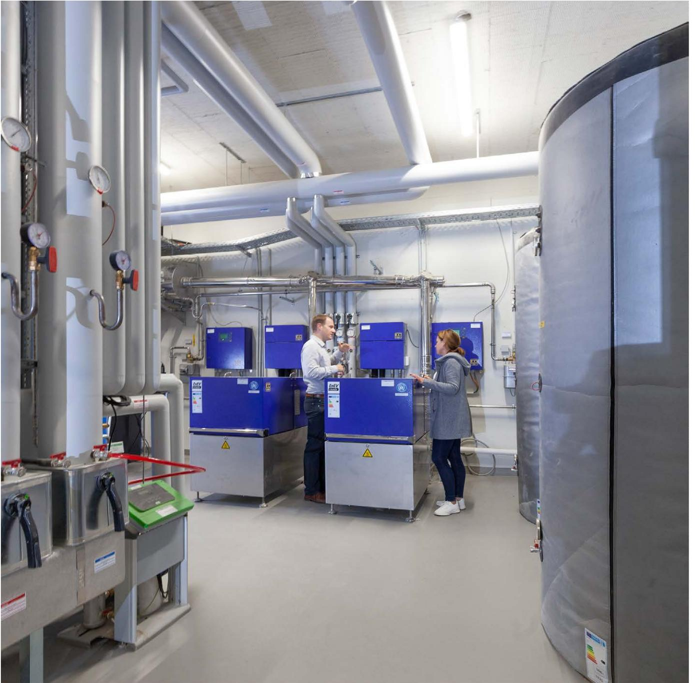
Heizzentrale mit Blockheizkraftwerken, Pufferspeicher und Heizungsverteilung
