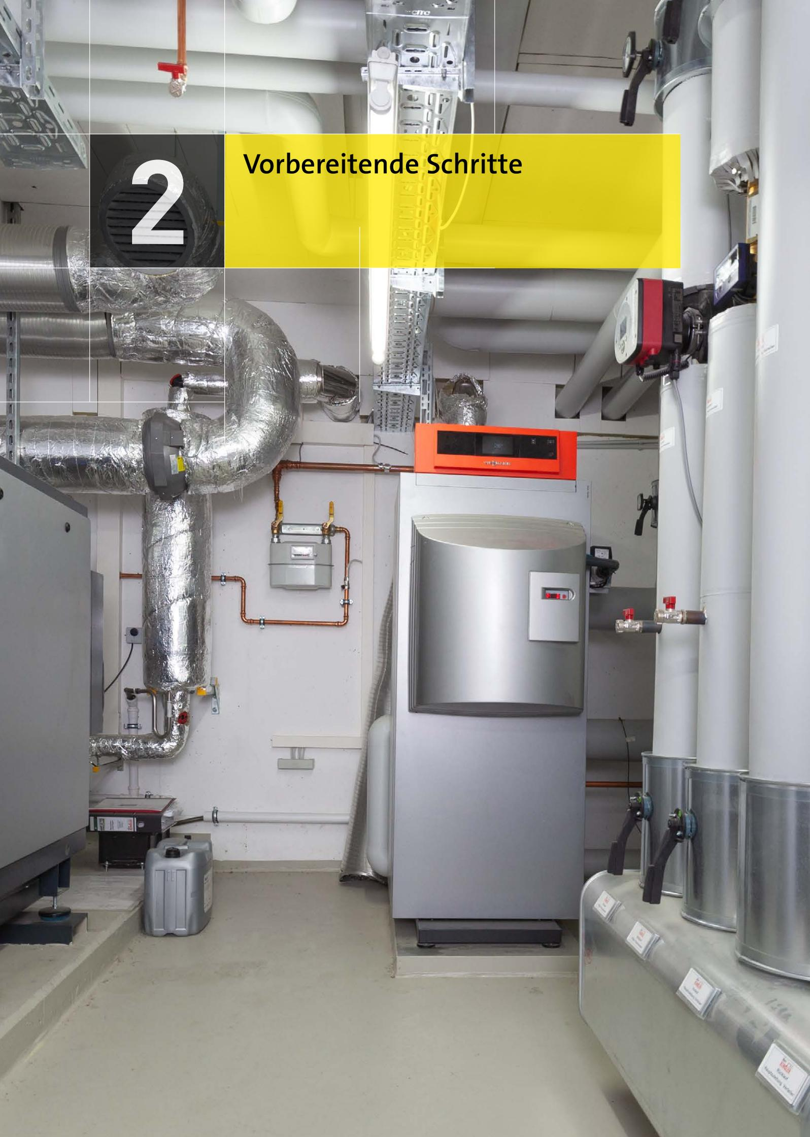
Im Rahmen der Projektvorbereitung wird ermittelt, ob und, wenn ja, welches BHKW im konkreten Objekt sinnvoll ist. Da ein BHKW in Wohngebäuden heute in der Regel wärmegeführt betrieben wird, ist dabei der Wärmebedarf des Objektes sehr wichtig. Zusätzlich ist es erforderlich, das BHKW um einen Spitzenlastkessel zu ergänzen. Der Grund lässt sich am besten an der geordneten Jahresdauerlinie darstellen.
