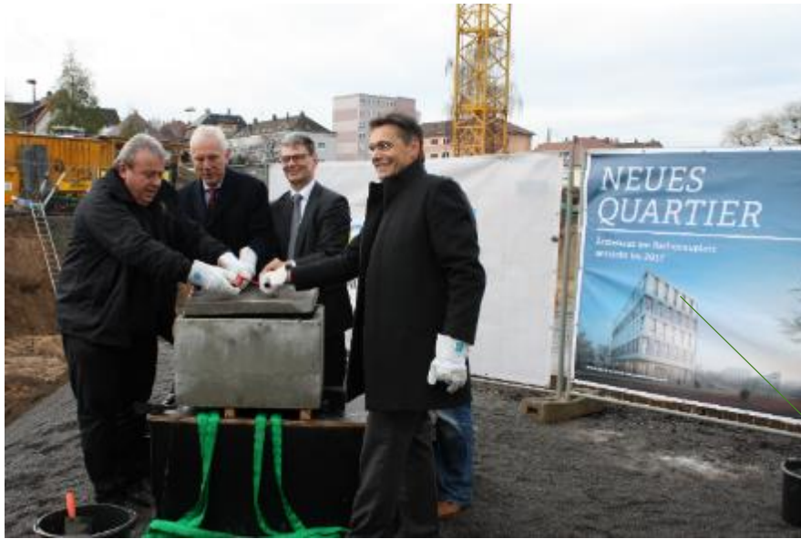
Grundsteinlegung ZEAG-Ärztehaus „QSÜD“ im Südbahnhof-Quartier im Dezember 2015
