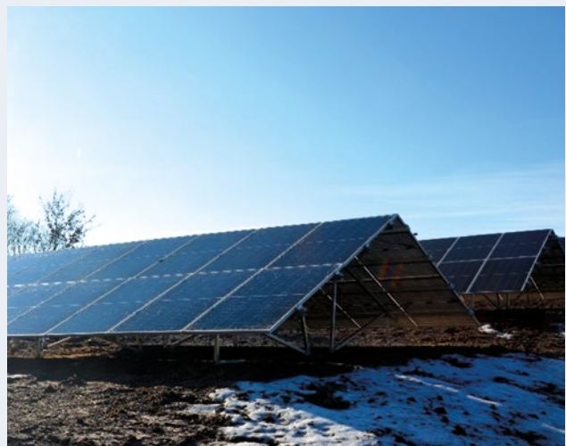
Boden-PV-Anlage im Bereich einer ehemaligen Simultan-Teichkläranlage. Quelle: Gemeinde Ebhausen
