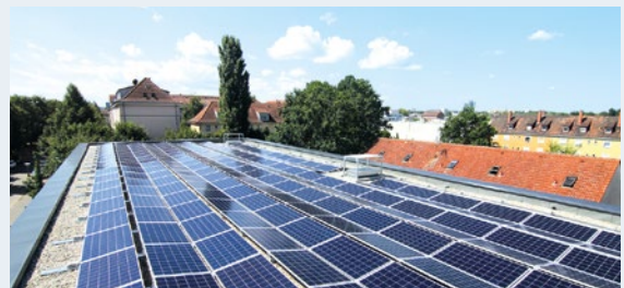
Die 99 kW-Photovoltaikanlage auf dem Dach liefert den Strom direkt an die Probabühne des städtischen Theaters.
