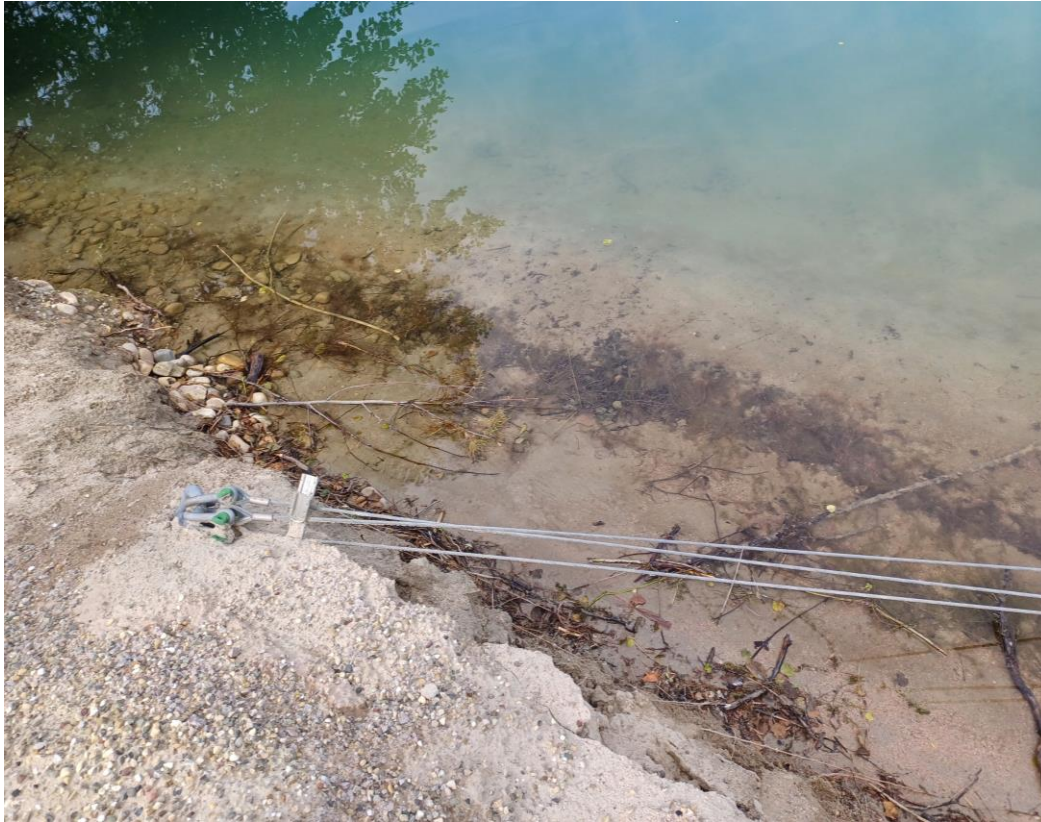
Verankerung der Floating-PV Quelle: eigene Aufnahme
