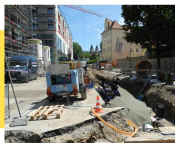
Verlegung von Wärmeleitungen in der Innenstadt: Durch den Ausbau der Fernwärme will Offenburg die Wärmewende vorantreiben
