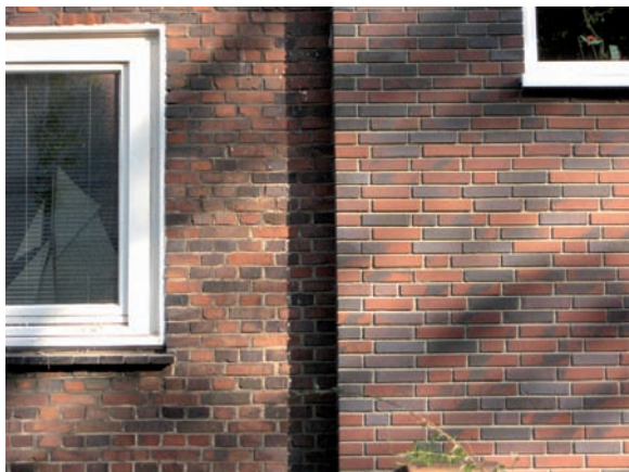
Lebendiger Klinkerbau vor der Sanierung, aalglatte „Riemchen“ vor Wärmedämmverbundsystem nach der Sanierung; Regionaltypische steinerne Fensterbänke werden deutschlandweit durch Kunststoff-Fensterbänke ersetzt.
