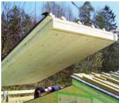
*Einsatz von vorgefertigten Vakuumdämmelementen (Quelle: Variotec)*
