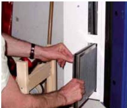
Filterwechsel: möglichst einfach (durch den Mieter)/kostengünstige Ersatzfilter
