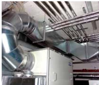
Lüftungszentrale für zehn Wohneinheiten mit hochwertigem Schalldämpfer für die Zuluft
