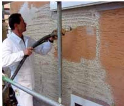
*Luftdichtung in der Kleber-Ebene des WDV bei Sanierung im bewohnten Zustand*
