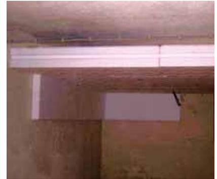
*Kellerdeckendämmung mit 14 cm Polystyrol*
