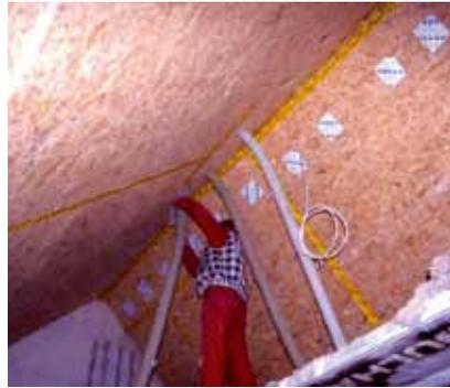
*Schrägdach-Dämmung mit Zellulose-Einblasdämmung*
