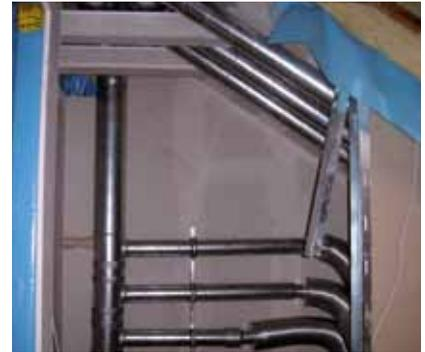
Verteilung: direkter Anschluss der Schalldämpfer an die Brandschutzklappen
