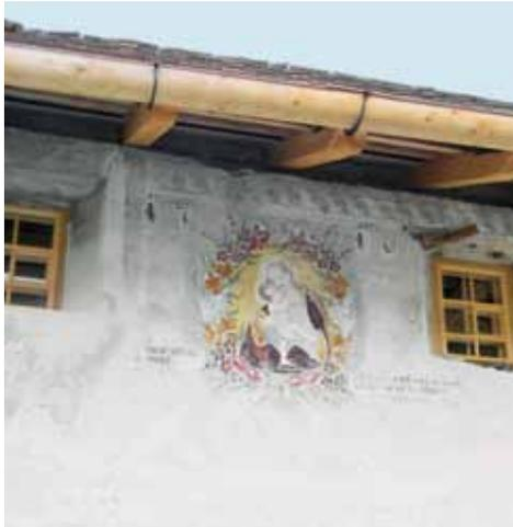
Konstruktiver Schlagregenschutz durch Dachüberstand
