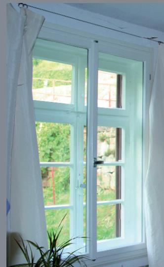
Umbau eines Einfachfensters zum Kastenfenster mit Isolierverglasung innen
