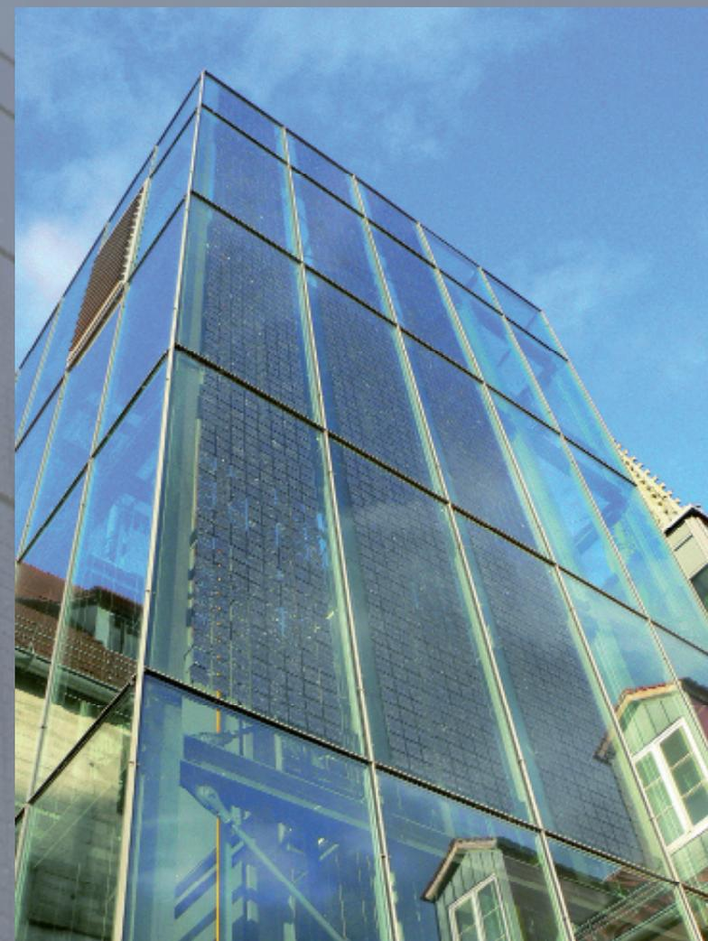
*Erschließungsbauwerk mit integrierter PV-Anlage in den Glasscheiben*
