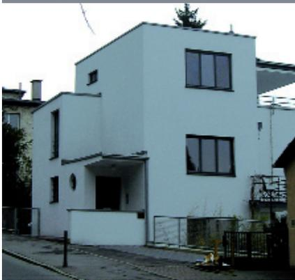
*Bauwerk der 30er Jahre, Sanierung der Fenster und Ergänzung zu Verbundfenstern, neue Heizanlage und Einsatz einer solarthermischen Anlage auf der Terrassenüberdeckung*
