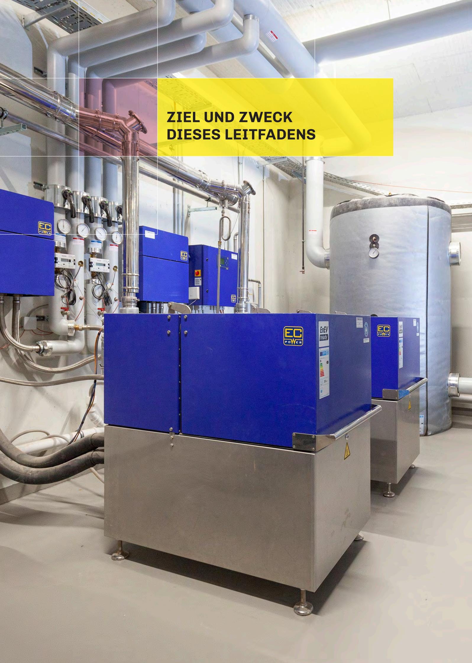
Kraft-Wärme-Kopplung (KWK) ist die gleichzeitige Erzeugung von Strom (Kraft) und Wärme, überwiegend aus Gas. Eine wichtige Anlagenart der Kraft-Wärme-Kopplung sind Blockheizkraftwerke (BHKW). Meist werden Verbrennungsmotoren genutzt, seltener Brennstoffzellen oder Stirling-Motoren.
