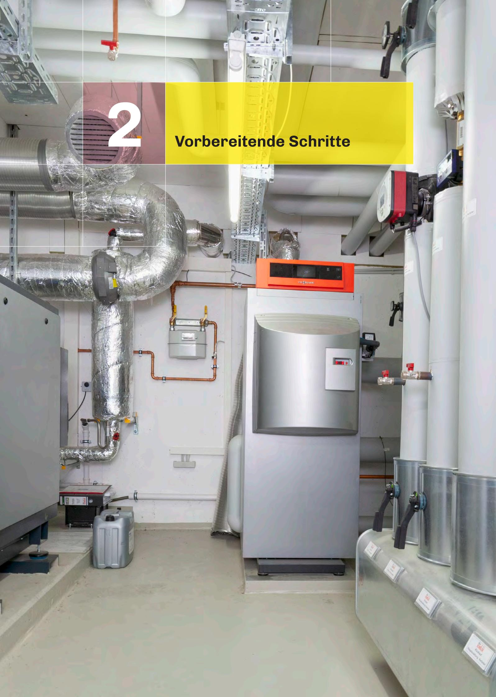
Im Rahmen der Projektvorbereitung wird ermittelt, ob und, wenn ja, welches BHKW im konkreten Objekt sinnvoll ist. Da ein BHKW in Wohngebäuden heute in der Regel wärmegeführt betrieben wird, ist dabei der Wärmebedarf des Objektes sehr wichtig. Zusätzlich ist es erforderlich, das BHKW um einen Spitzenlastkessel zu ergänzen. Der Grund lässt sich am besten an der Jahresdauerlinie darstellen. Diese stellt die über das Jahr anfallende Wärmelast sortiert nach Größe dar.
