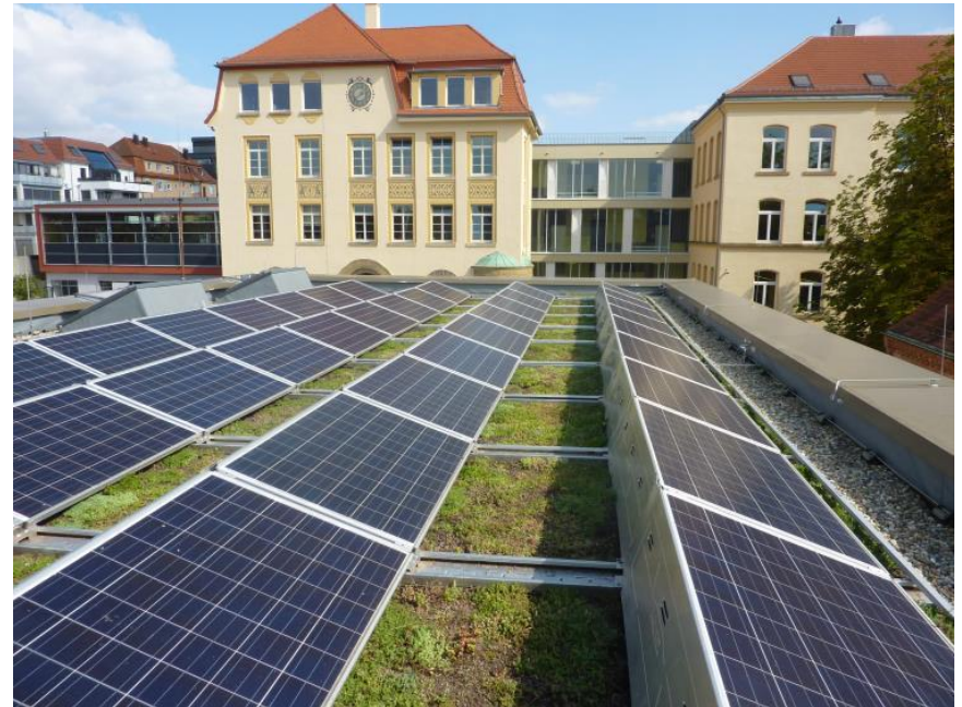
Dachbegrünung und Photovoltaik, Neubau Mensa Ludwigsburg; Quelle: Stadt Ludwigsburg
