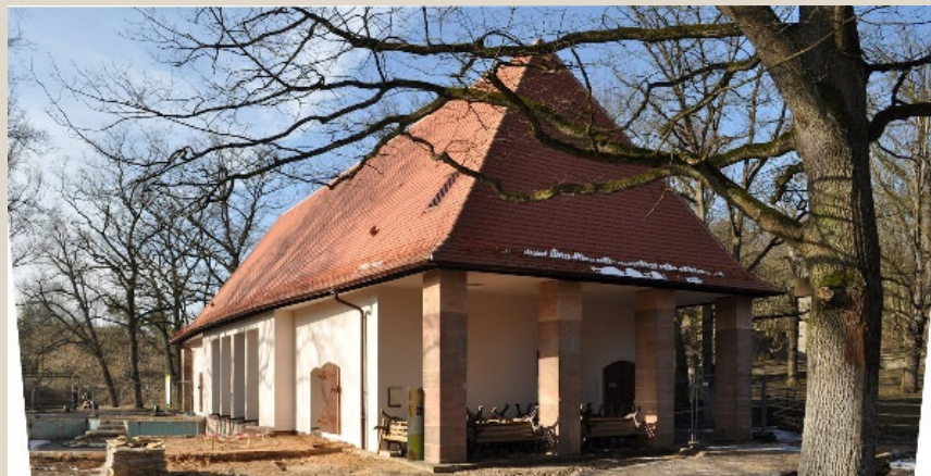
Sanierung und Umnutzung Wüstenhaus (2016-2018)
