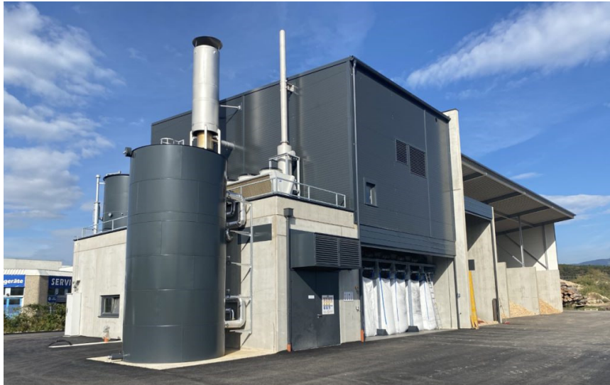
Abb. 8: Biomasse-BHKW mit CO 2 -Abscheidung durch Pflanzenkohle Quelle: https://www.syncraft.at/media/news/details/das-neue-schwarze-gold
