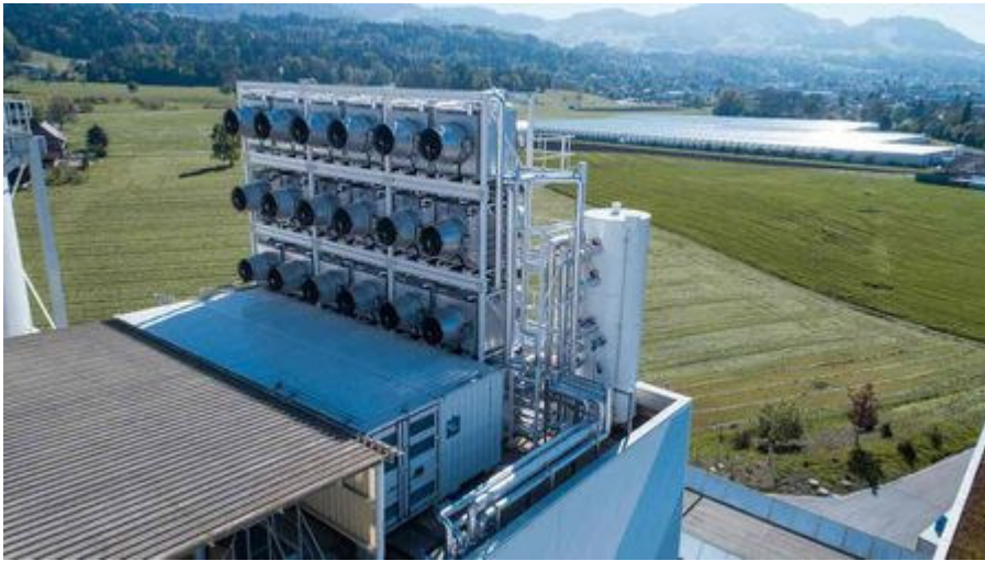
Abb. 7: Versuchsanlage in der Schweiz zur CO 2 -Abscheidung Quelle: https://www.sciencemag.org/news/2017/06/switzerland-giant-new-machine-sucking-carbon-directly-air
