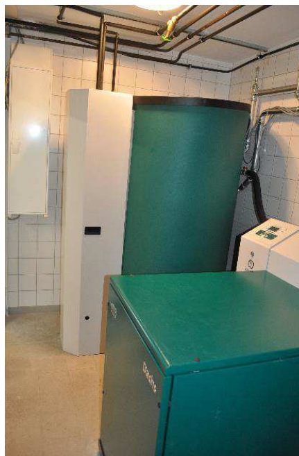
Heizraum mit BHKW, statische Heizung Halle, Lüftung
