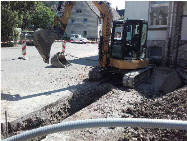
Tiefbauarbeiten Nahwärmetrasse
