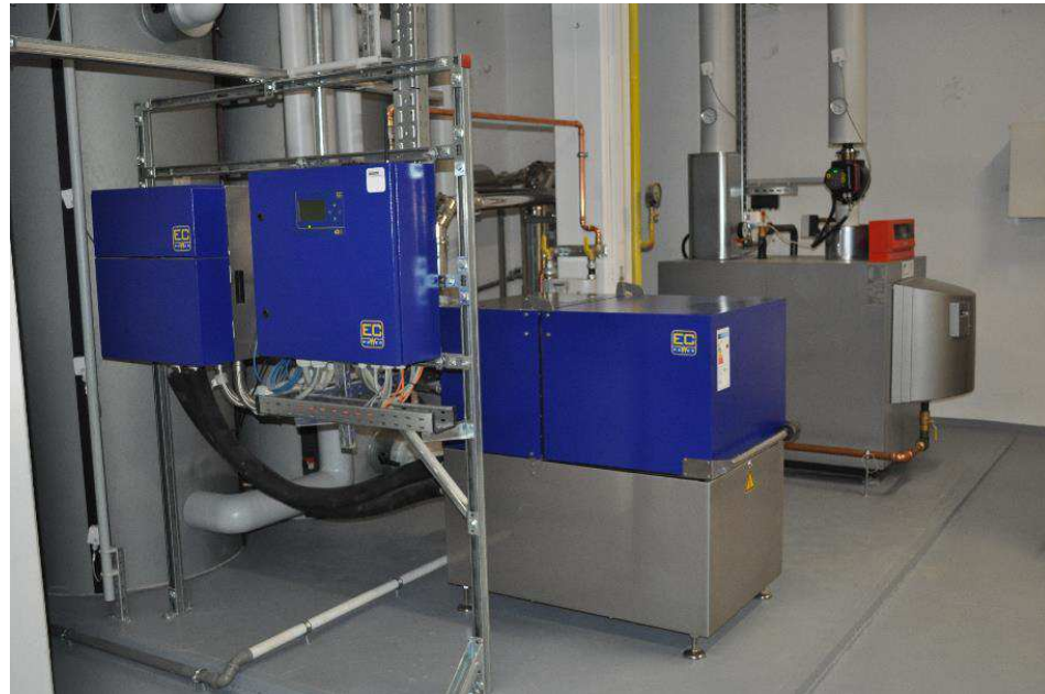
Zustand der Heizzentrale nach der Sanierung
