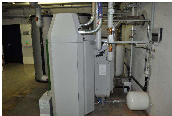
Neue Pellets-Brennwertheizung mit Pufferspeicher
