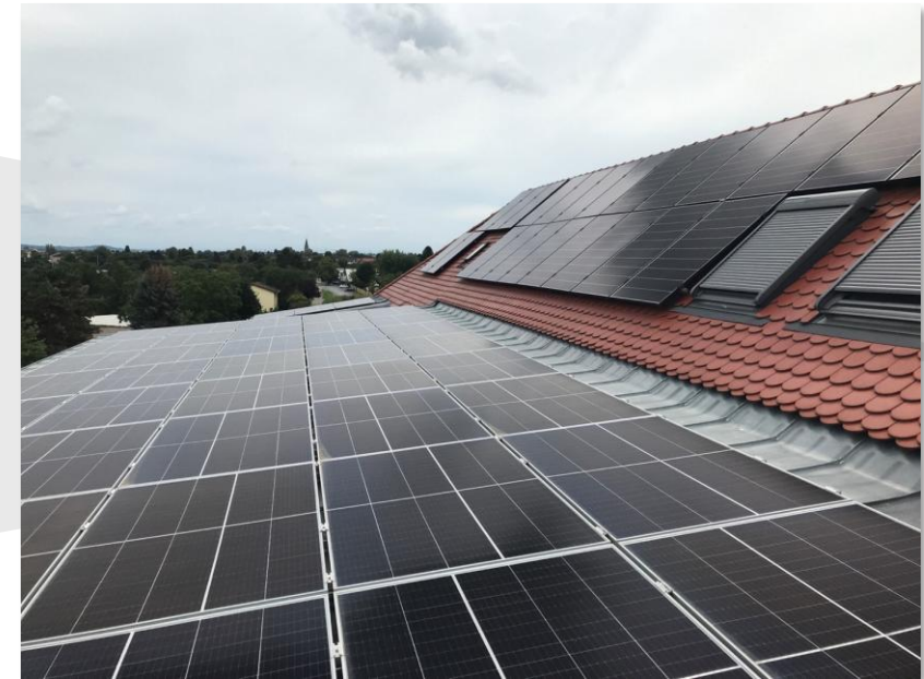
PV-Anlage iWerkX Heidelberg
