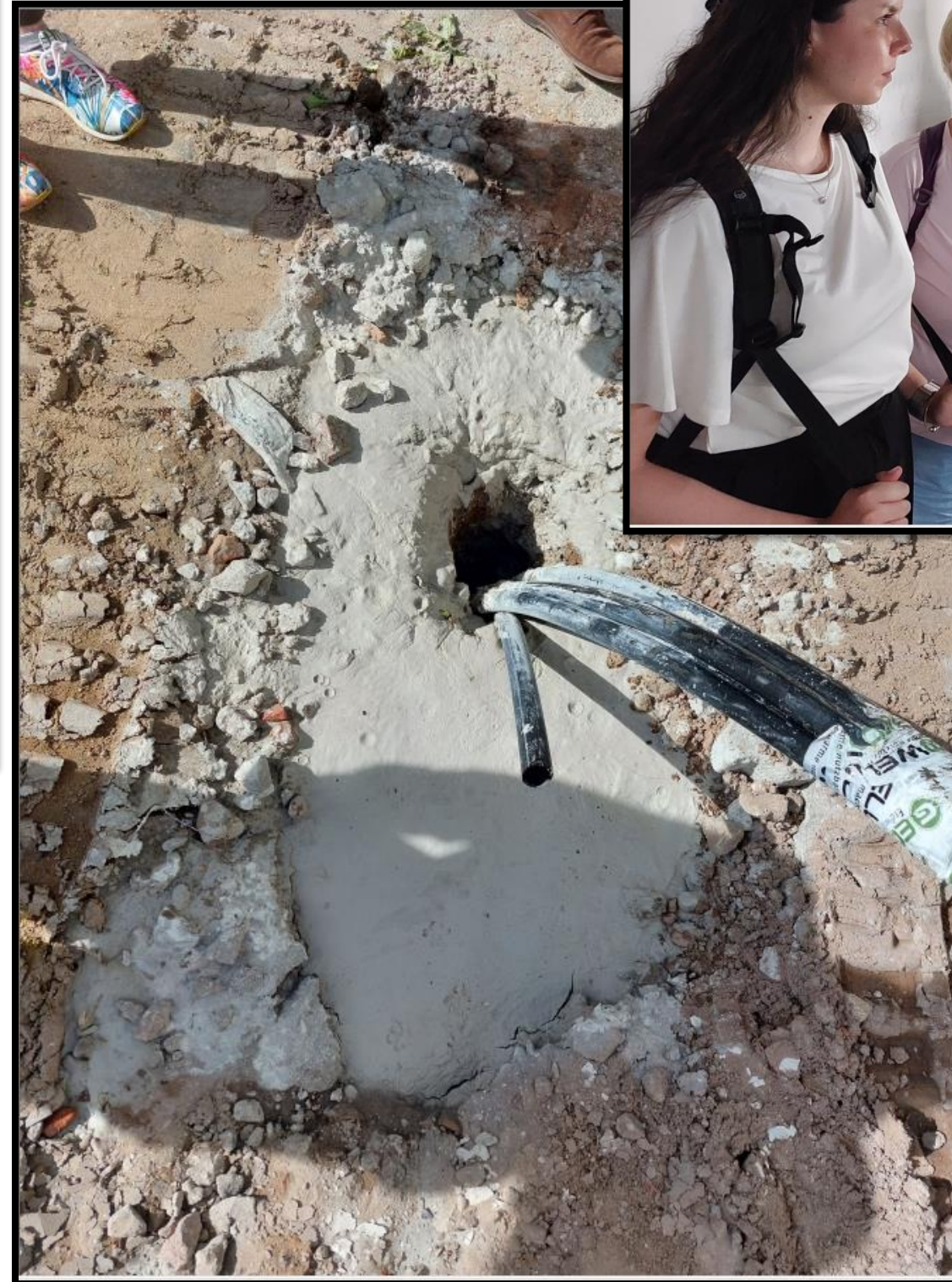
Stadtwerke Schifferstadt: Verlegung kaltes Nahwärmenetz Rathaus Schifferstadt
