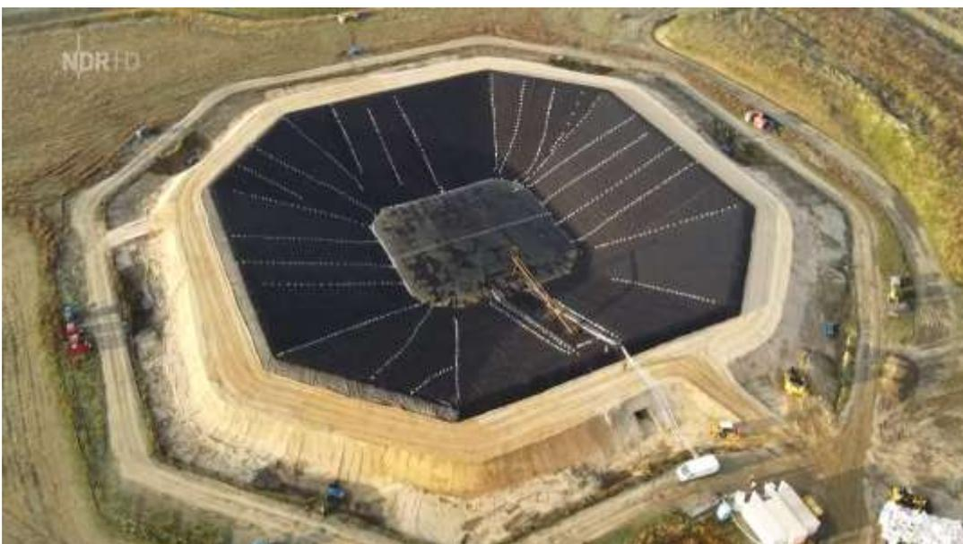
**Abb. 23: Bau Erdbeckenwärmespeicher Meldorf mit rd. 43.000 m<sup>3</sup> (Bild: [www.ramboll.com](http://www.ramboll.com))**
